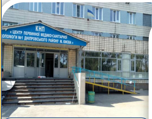
Ремонт внутрішніх світлопрозорих конструкцій на вул. П.Запорожця, 26
