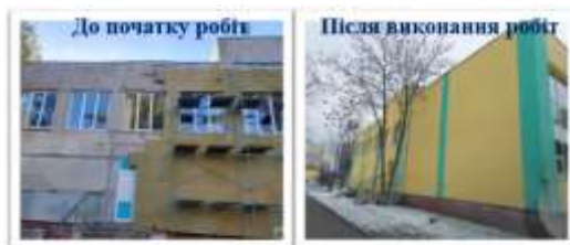
Утеплення фасаду Навчально-виховного комплексу № 30 «ЕкоНад» площею 400 м 2 мінераловатними плитами з декоративним оздобленням
