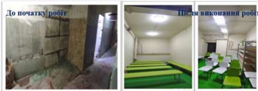
Ремонт захисної споруди у спеціалізованій школі I-III ступенів № 234 (ремонт п'яти кімнат, місць загального користування, замінено електропроводку та дев'ять дверних блоків, обладнано новий санвузол)
